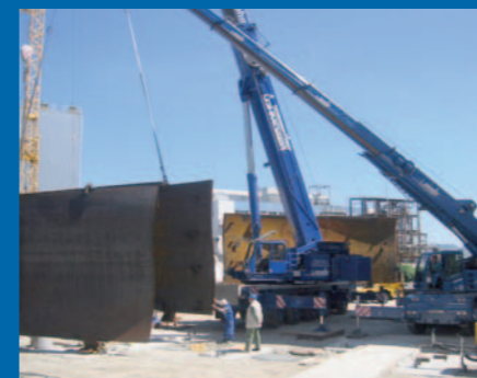
Entladen und Positionierung mit Kran → Ausrichten und Endmontage nach Kundenvorgaben → "Dirk's Pod" auf dem Novartis-Campus des Wissens.
